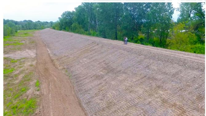
Новітнім підходом відносно українських стандартів вважається влаштування по гребеню дамби на всій її довжині (9,5 км) експлуатаційної дороги нежорсткого полегшеного типу покриття, що було виконано по ширині 3,0 м з встановленням сигнальних стовпчиків.
